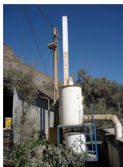
Sr. Luis Piñones verificando en terreno, los trabajos de mejoramiento en el sistema de extracción y lavado de gases del laboratorio químico, que incluyó la extensión de la chimenea y reparaciones del sistema de lavado.
