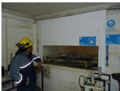
Sr. Luis Piñones verificando en terreno, los trabajos de mejoramiento en el sistema de extracción y lavado de gases del laboratorio químico, que incluyó la extensión de la chimenea y reparaciones del sistema de lavado.
